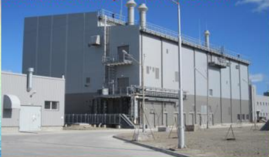
Strahl- und Beschichtungshalle für Reaktorsectionen und weitere Großkomponenten im LZL Saida
