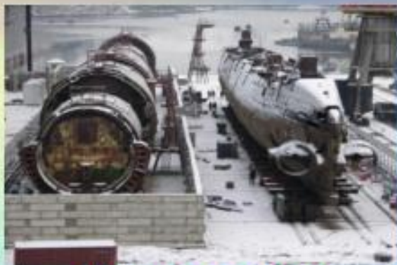
Bau eines neuen Zerlegeplatzes
